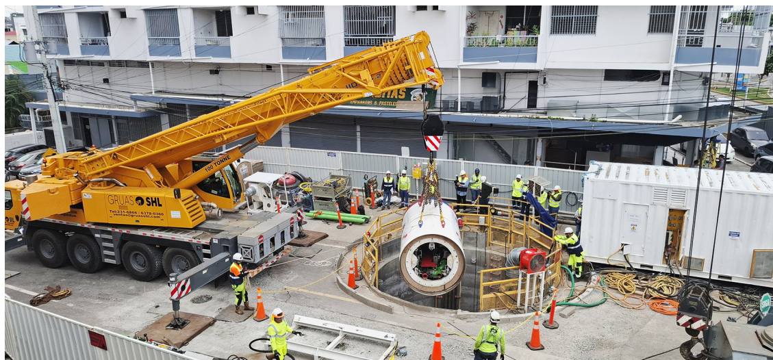
Izaje e ingreso de la microtuneladora Margarita Pozo CI-13 A - 3 en ciudad de Panamá como hito importante dentro del proceso de modernización de la Red de Saneamiento de Panamá
