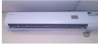
Aire Acondicionado modelo de 24000 BTU para el cuarto de urgencias
