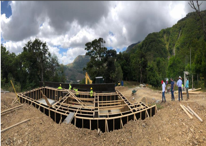
Construcción del pre-filtro del sistema de acueducto de la comunidad de Maracas
