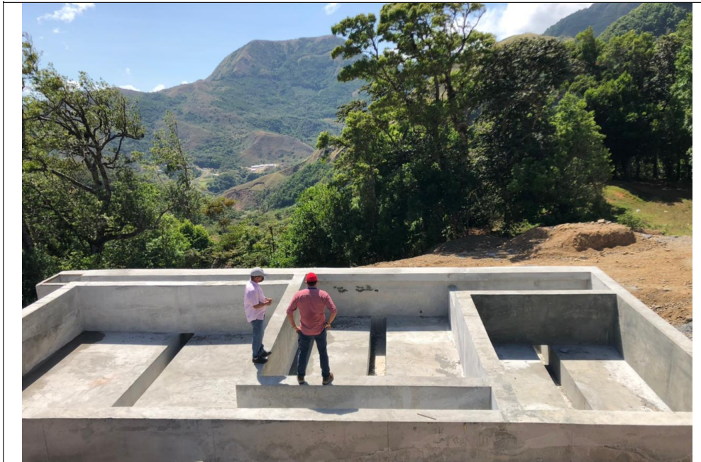
Evaluación de la estructura del pre-filtro del sistema de acueducto de la comunidad de Maracas
