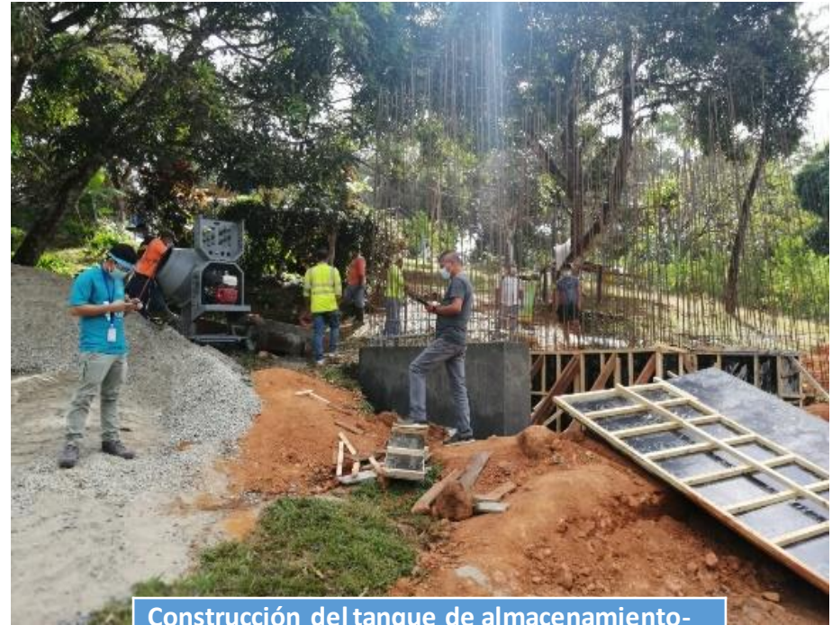
Construcción del tanque de almacenamiento- La obra sanitaria tiene un avance de 40%
