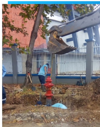
Instalación de hidrante en Campo Limberg, Estadio Rommel Fernández
