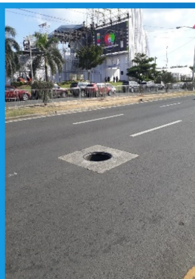
Colocación de tapa sobre alcantarillado sanitario en Avenida Balboa
