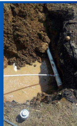
Reparación de tubería de 3 plg pvc en Buena Vista Colón
