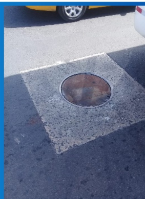
Colocación de tapa sobre alcantarillado sanitario en Avenida Balboa
