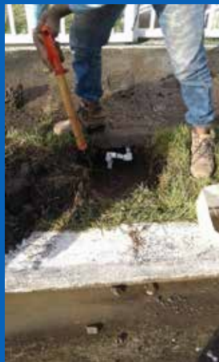
Reparación de tubería de ¾ plg en Campo Limberg.
