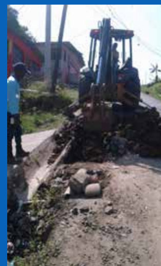
Reparacion de tuberia de 10 plg. En Pancho Aleman San Miguelito.
